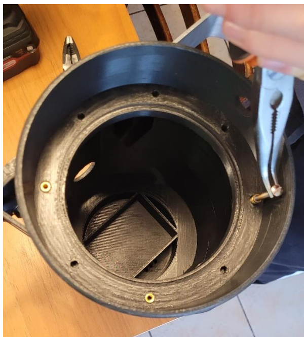
Obrázek 30: Zapouštění závitových vložek M4, Zdroj: vlastní
