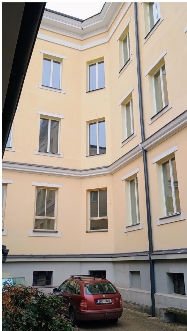
Obrázek č. 27 – Gymnázium Náchod – pohled na prostor umístění plánovaného výťahu
