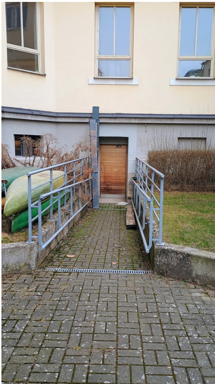
Obrázek č. 25 – Gymnázium Náchod – bezbariérový vchod
