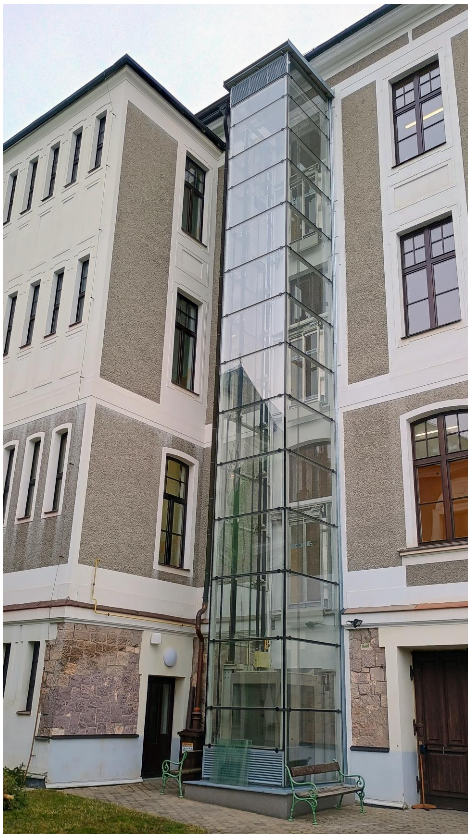
Obrázek č. 19 – Gymnázium Broumov – pohled na výtah ze dvora budovy
