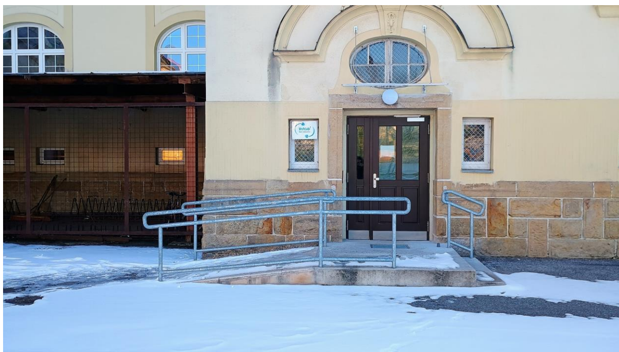
Obrázek č. 4 – Gymnázium Vrchlabí – pohled na vedlejší vchod
