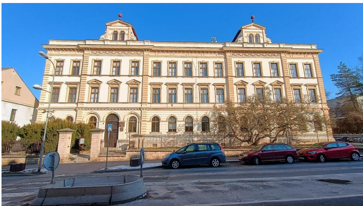
Obrázek č. 13 – Gymnázium Jičín – celkový pohled na jižní fasádu a hlavní vstup
