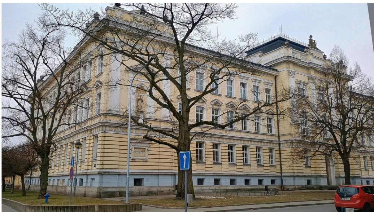
Obrázek č. 23 – Gymnázium Náchod – celkový pohled na východní nároží
