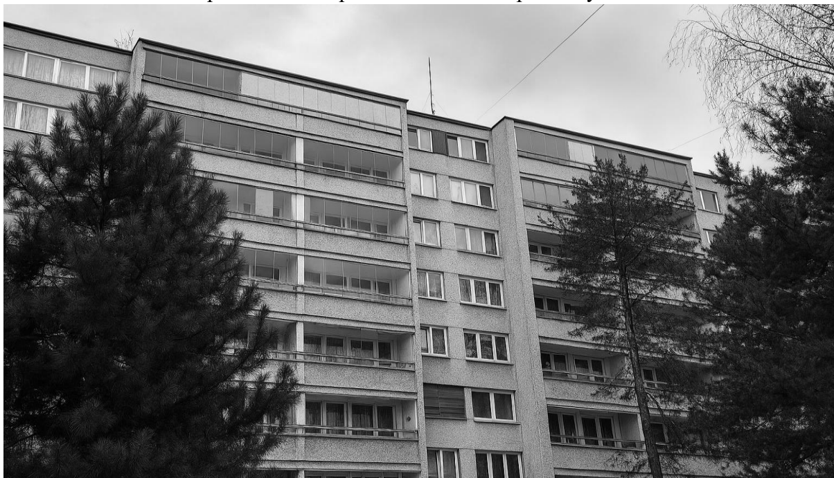
Obr. č. 22 – Současný stav panelových domů
