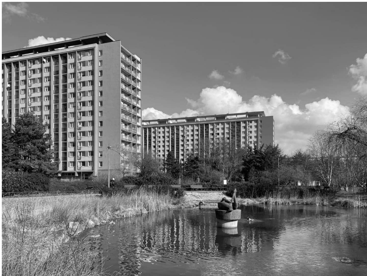
Obr. č. 12 – Panelové domy Sídliště Ďáblice
