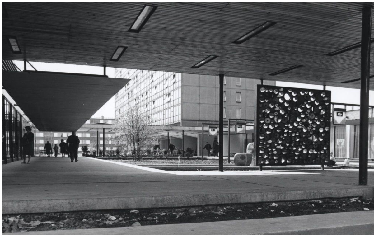
Obr. č. 6 – Výstup z metra – sídliště Invalidovna
