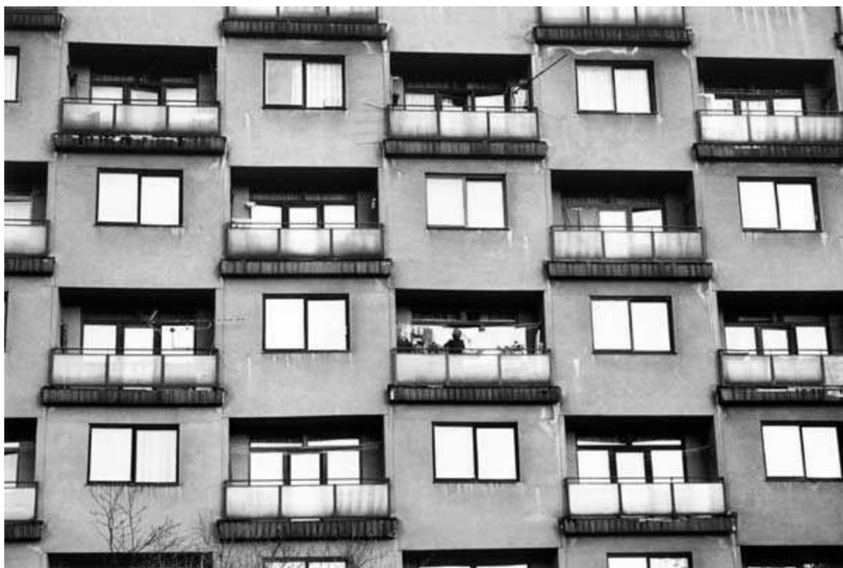
Obr. č. 8 – Detail balkónů panelového domu
