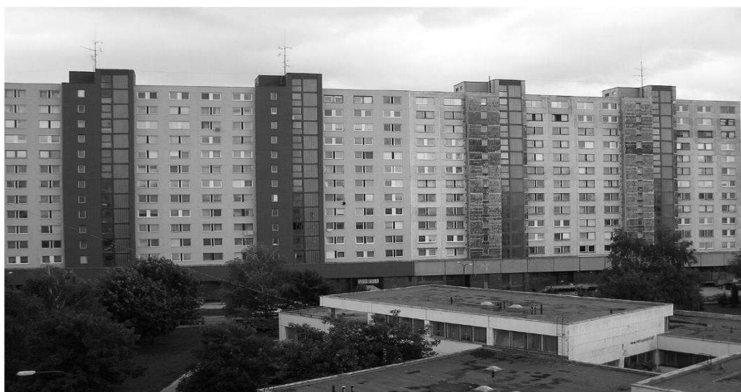
Obr. č. 9 – Pohled na panelový dům
