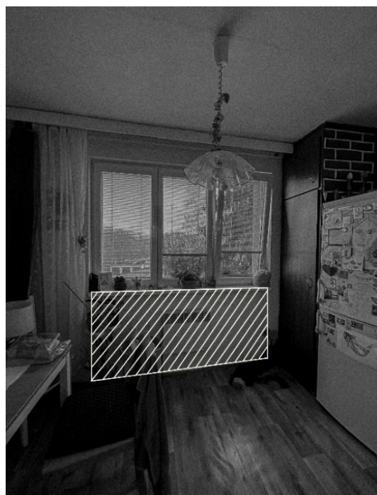
Obr. č. 46 – Odstranění parapetů
